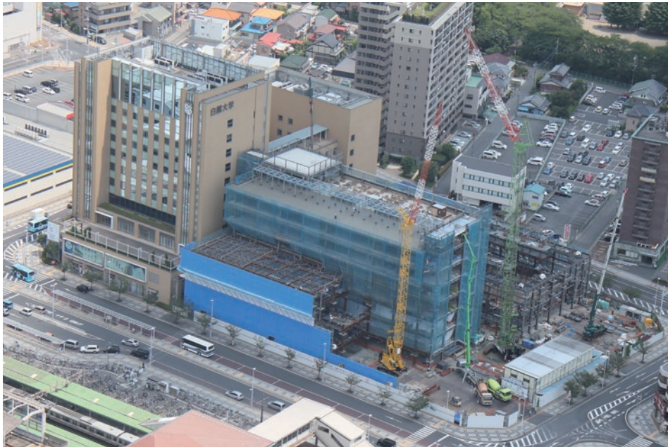
8階建ての基本構造が完成した新棟(2017年7月21日撮影)
